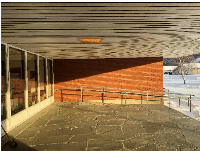
Figur 1 – Rampe ved hovedinngang
