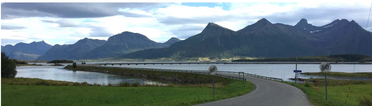
Figur 8: Dagens lavbru sett fra Ålstad på Engeløya
