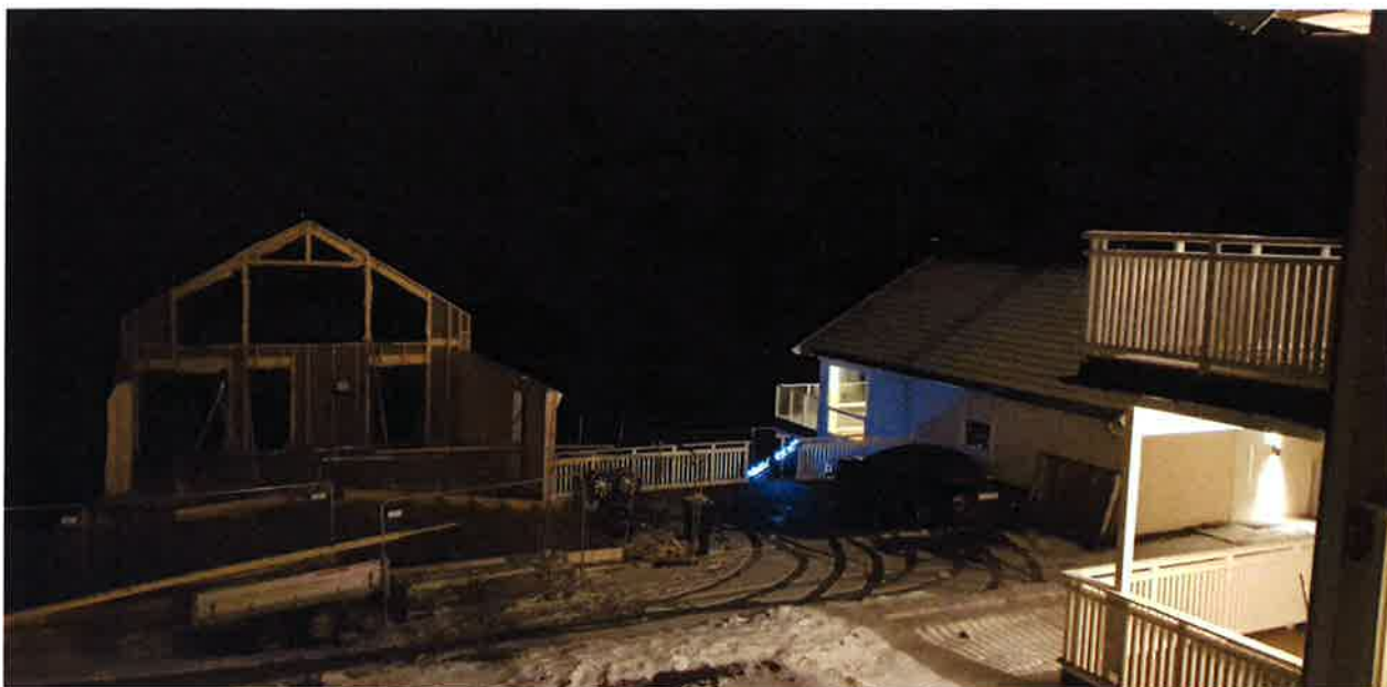
Bildet viser byggestart på hus 6 på gnr. 5 bnr. 135.
