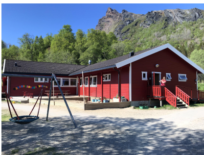
Barnehagebygget sett fra adkomst.
