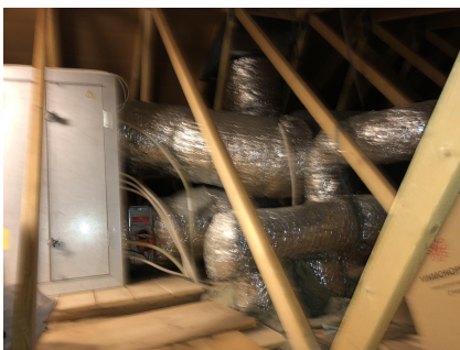
Ventilasjon på kaldloft.
