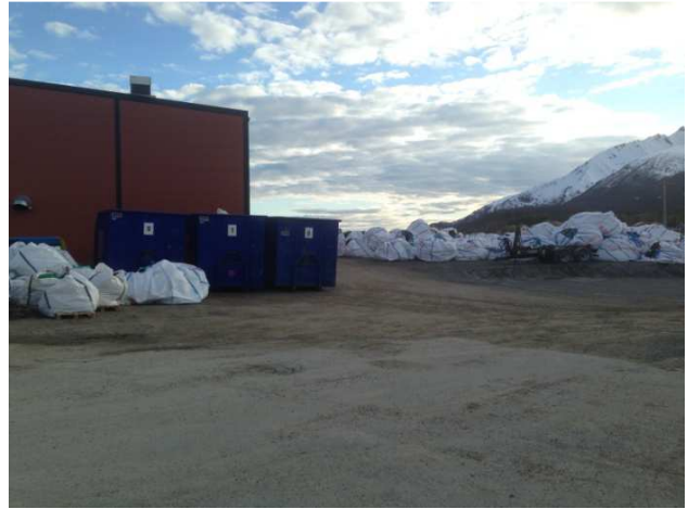
Del av fasade mot øst for hall på gnr/bnr 98/40 og utelagring av notposer.
