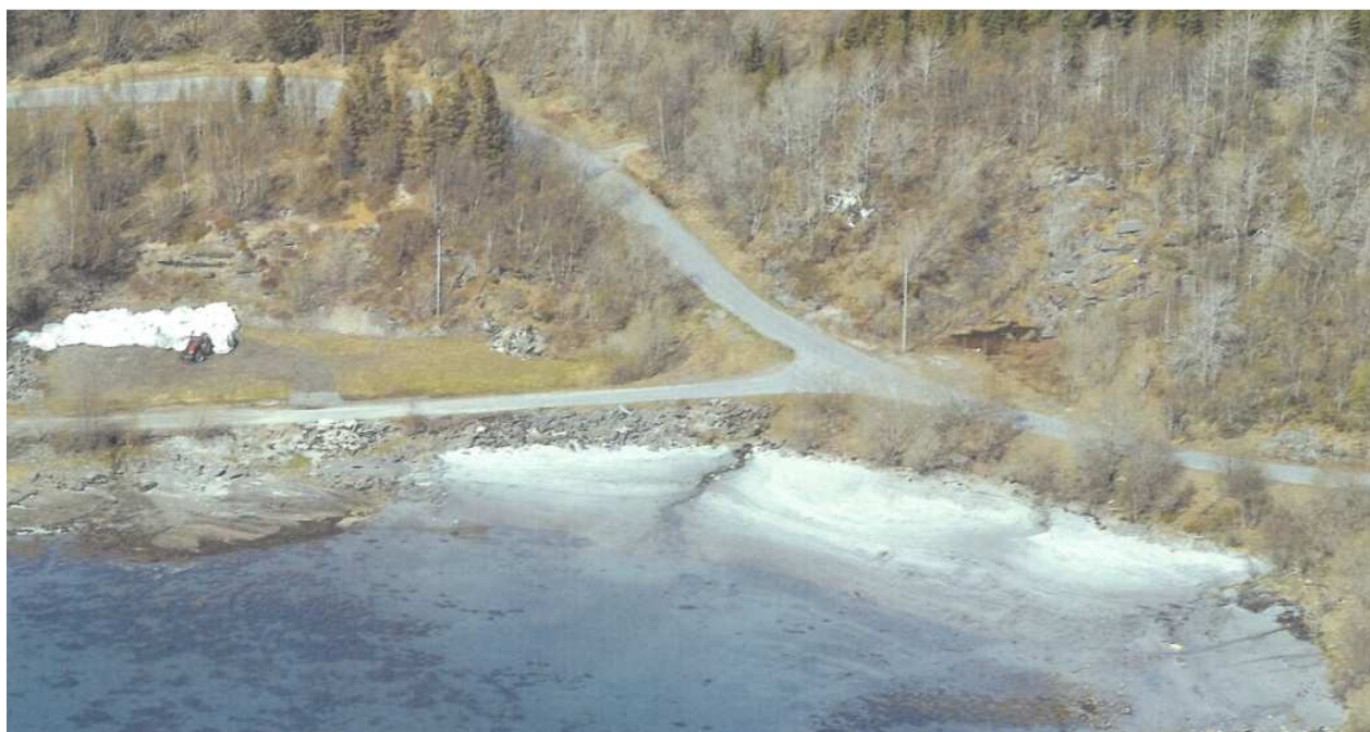
Flyfoto av dagens avkjørsel fra fylkesveg 631
