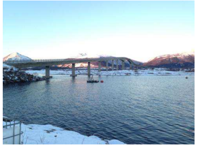
Engeløybrua og Bogøya sett fra Storskjæret.
