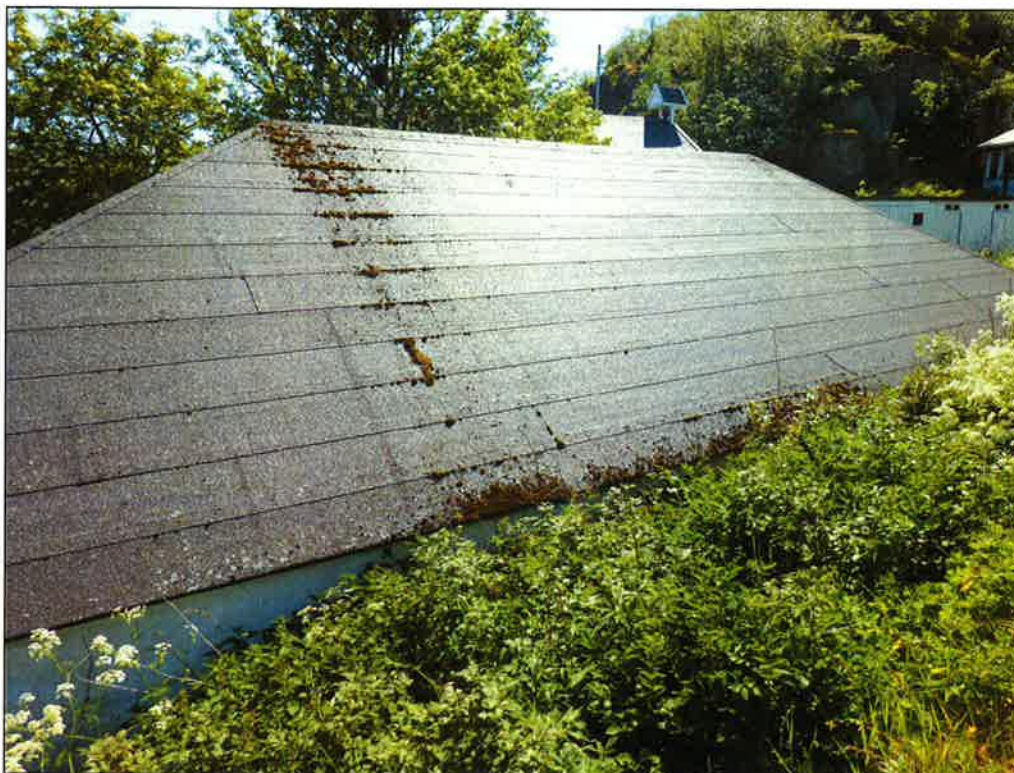
Sjåen mot nord, taket kledd med papp.
