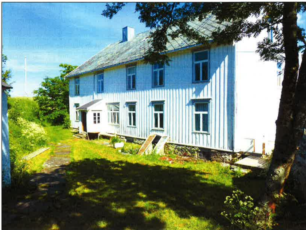
Baksiden av hovedbygningen mot vest, med kjøkkeninngangen og nedgang til kjeller.
