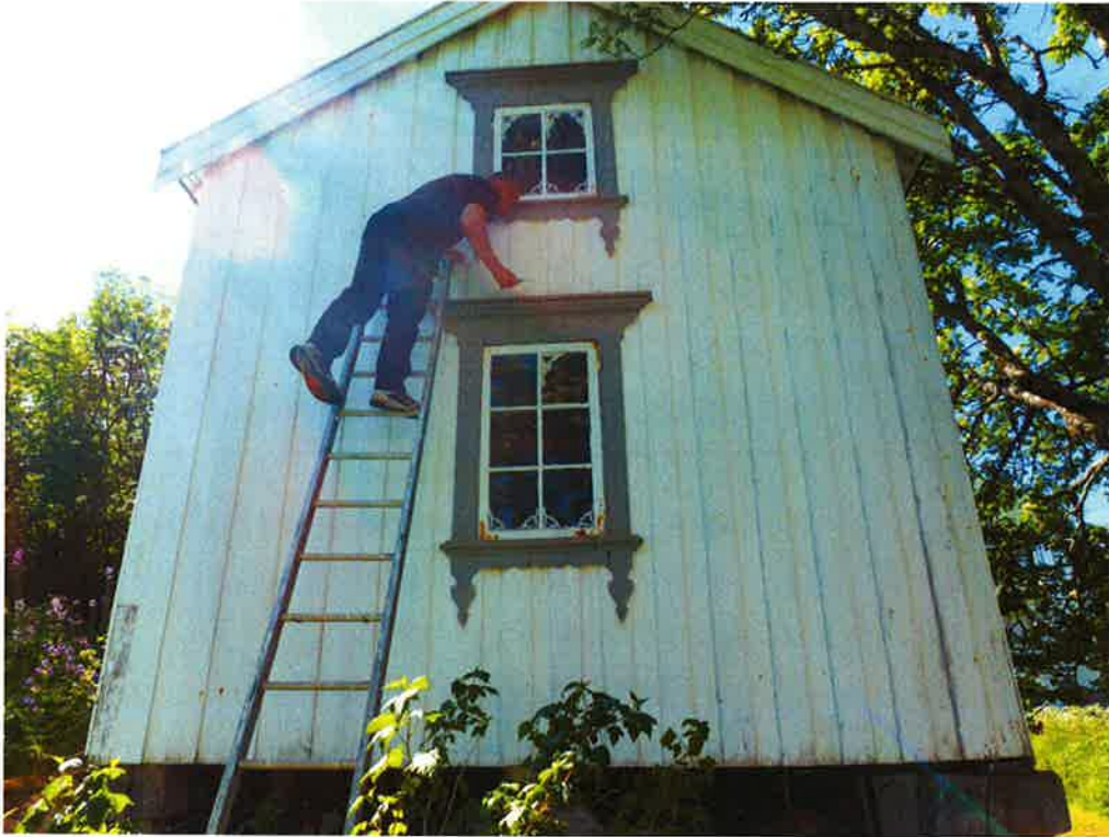
Stabburets gavl mot øst.
