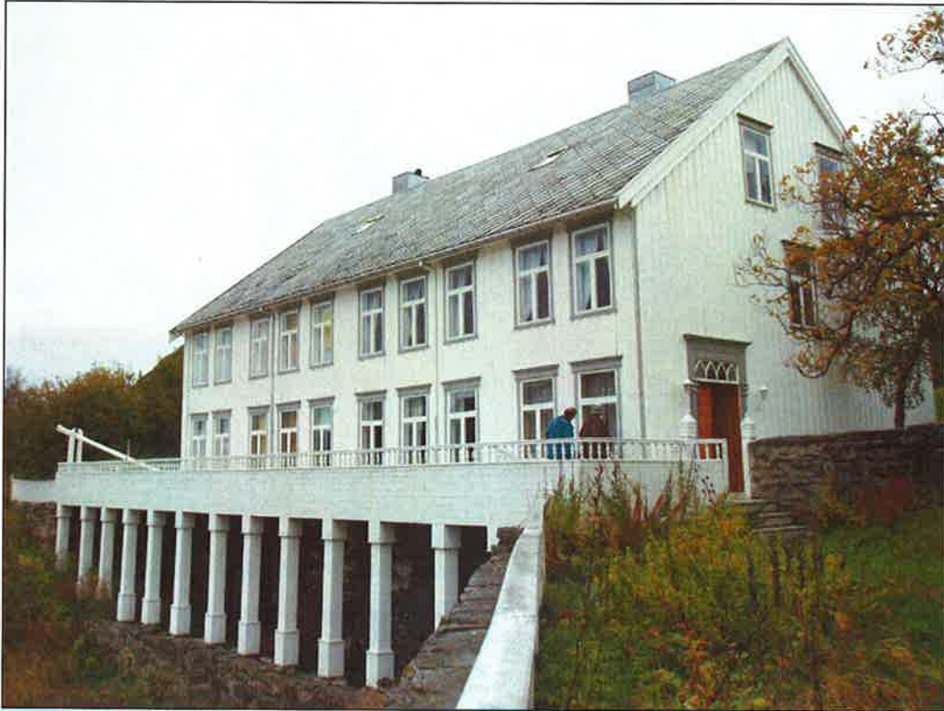
Hovedfasaden på hovedbygningen mot øst og hovedinngang på gavlveggen mot nord.
