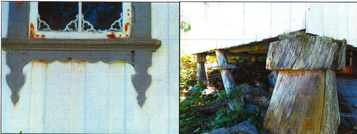
Til venstre: Detalj av vindusomramming. Til høyre: Stabber som stabburet er fundamentert på.
