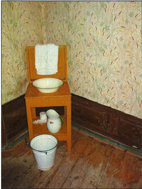
Interiør med gjenbruk av eldre fotpanel.
