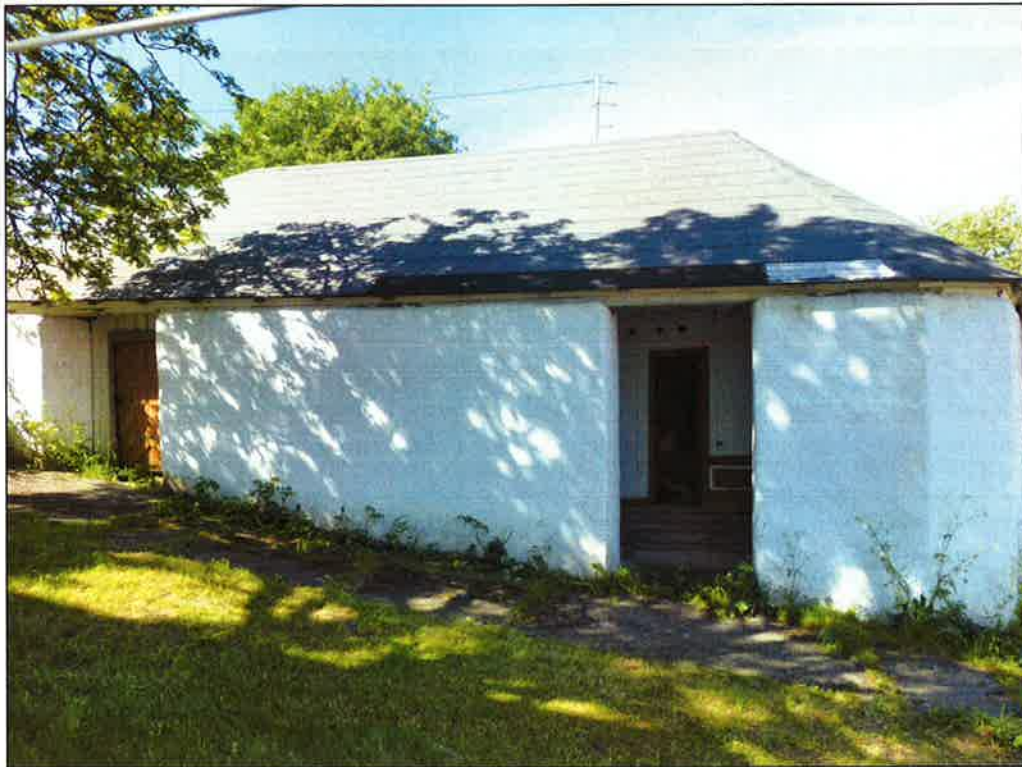
Sjåens fasade mot sør.
