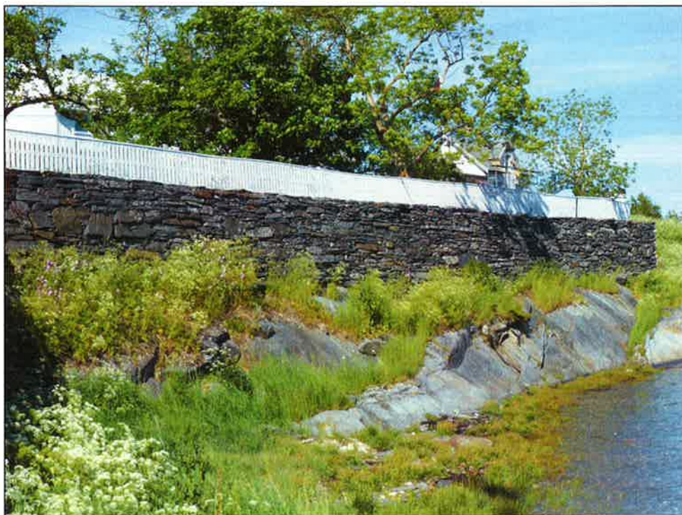
Oppbygd mur og gjerde rundt hageanlegget, mot nord.
